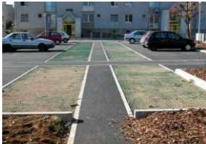
Figure 35 : Vue sur une chaussée à structure réservoir
