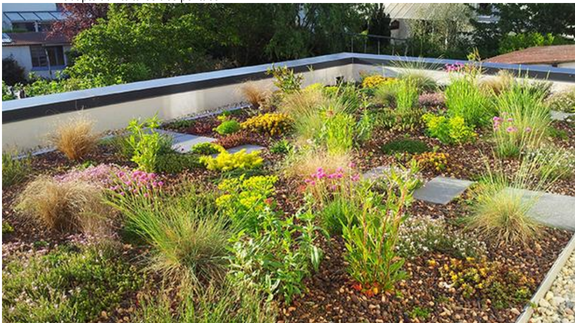
Figure 36 : Exemple d'une toiture terrasse végétalisée
