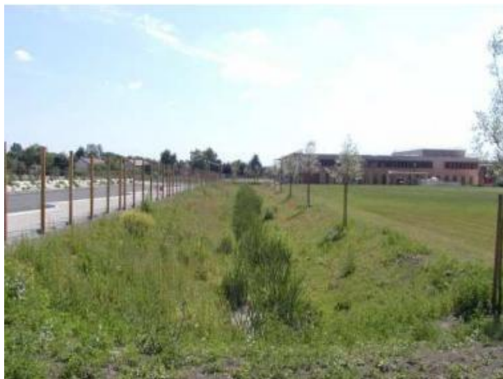
Figure 34 : Exemple d'une noue
