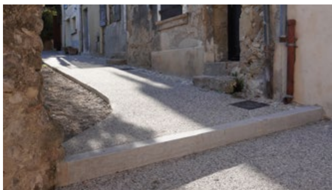
Aménagement de la Rue Roderie
