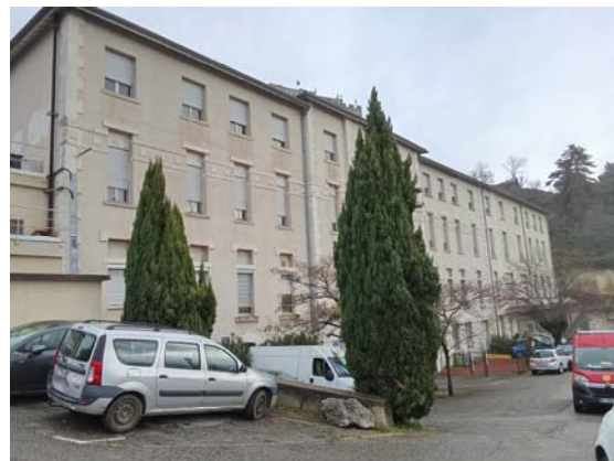
Vue vers le Nord-Est
